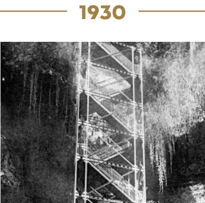
1930 Toujours en mouvement ! L'aménagement se poursuit avec l'installation du premier ascenseur, afin de faciliter la descente du Gouffre.
